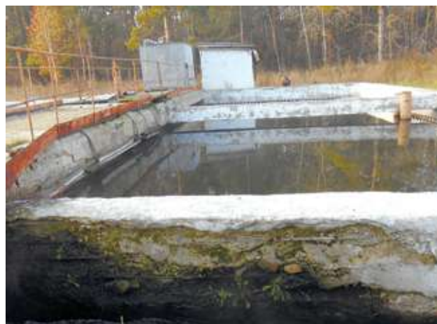
Рисунок 3 Разрушающийся отстойник.
