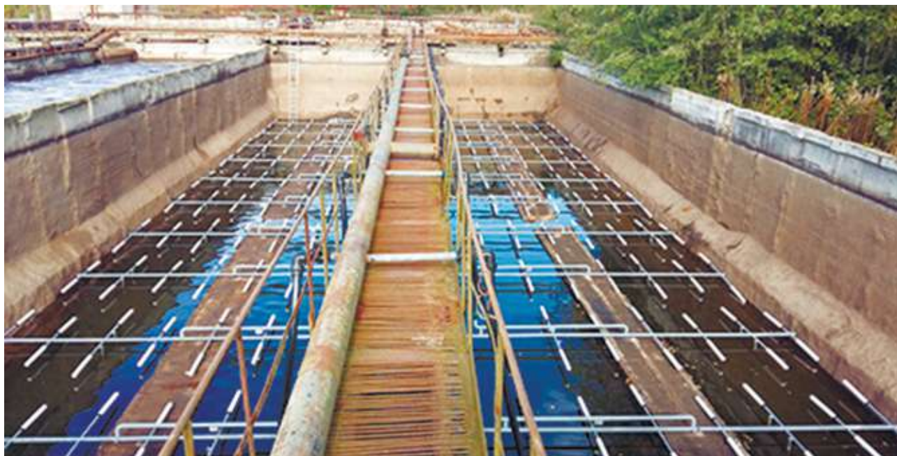
Рисунок 1 Система аэрации.
