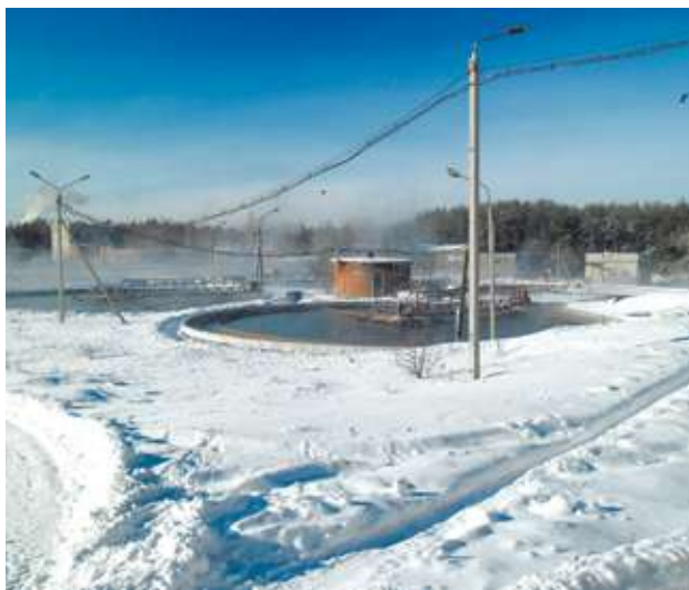
Рисунок 1 Общий вид очистных сооружений зимой.
