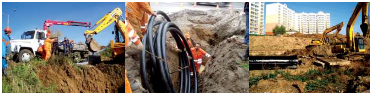
Рисунок 7 Ремонтные работы на сетях.
