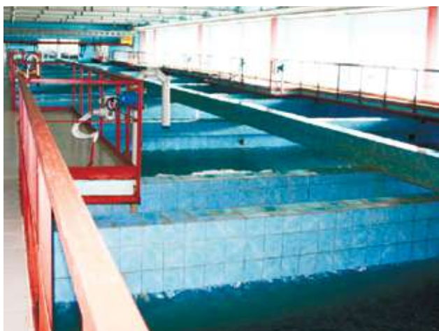
Рисунок 1 Скорые безнапорные фильтры.
